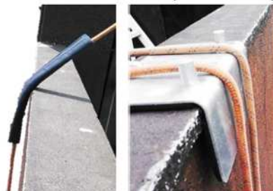
切断防止措置の例 (置き型養生) ▲
