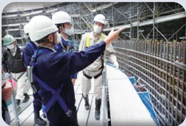
労働局による現場パトロール
