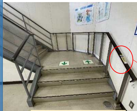
手すり追加(両側)
