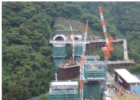
パトロール工事現場全景
