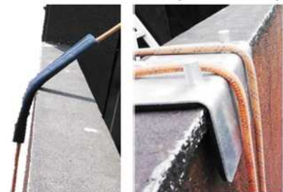
切断防止措置の例 (置き型養生) ▲
