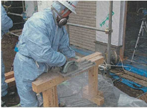
波型スレート切断作業
