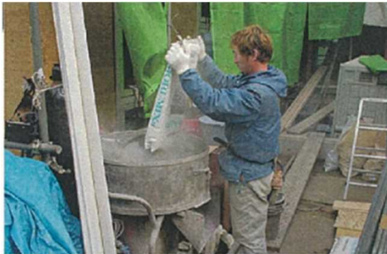
モルタル投入作業
