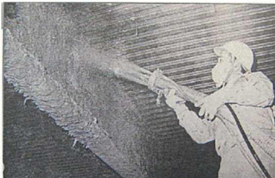
石綿を含む耐火被覆の吹付作業
