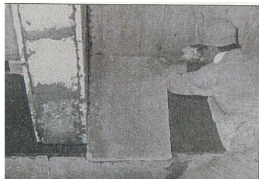
耐火被覆用石綿板の貼付け
