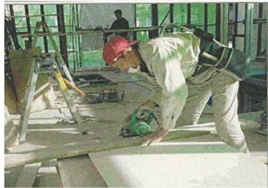
石綿ケイカル板切断作業
