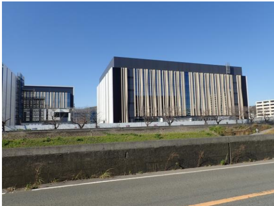
パトロール工事現場の建物の一部
