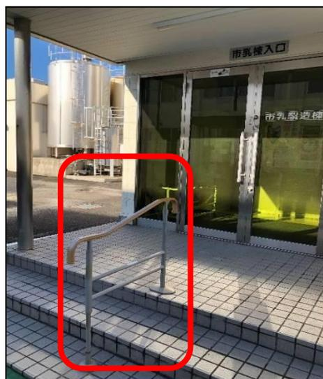
階段の基礎のわずかな段差をオレンジに塗り、さらに床に「段差注意」を掲示。また、得意先にて建物の入口部分にも手すりを設置。
