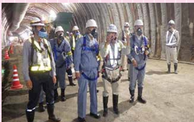
労働局による現場パトロール
