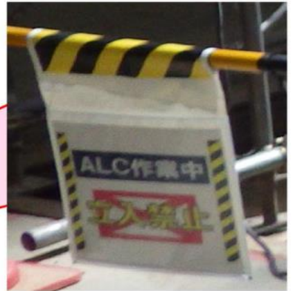
立入禁止表示 ・ 作業内容の表示
