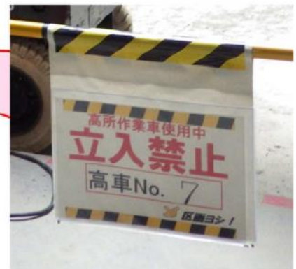
立入禁止表示 ・ 作業内容の表示
