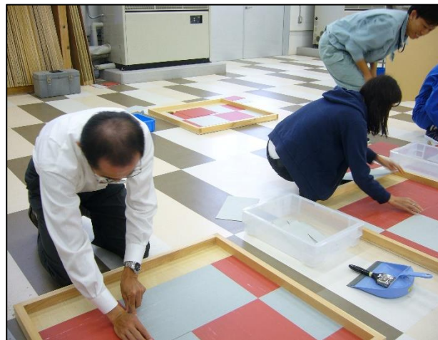
住環境リノベーション体験（床タイル施工）
