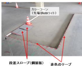
床面段差・段差スロープ位置の見える化（転倒災害防止）
