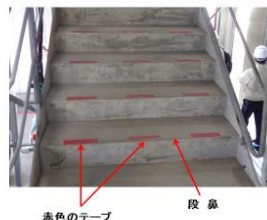
階段段差の見える化（階段からの墜落・転落災害防止）
