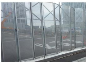
工事現場出入口周囲の見える化
