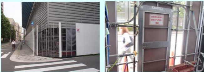
旋回半径の見える化(重機災害・激突され災害防止)
