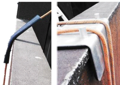
切断防止措置の例 (置き型養生) ▲
