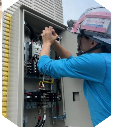
(開閉器盤の取付)
