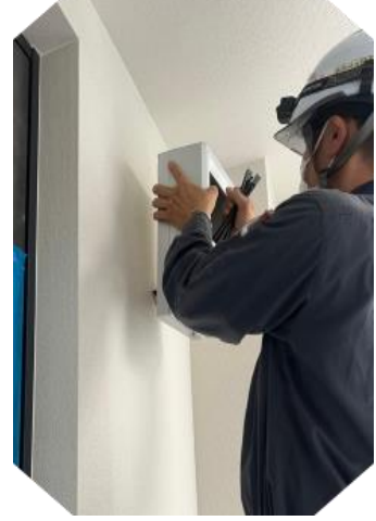
(メーターボックスの取付)
