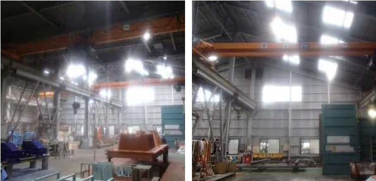
C棟クレーン室 D棟クレーン室
