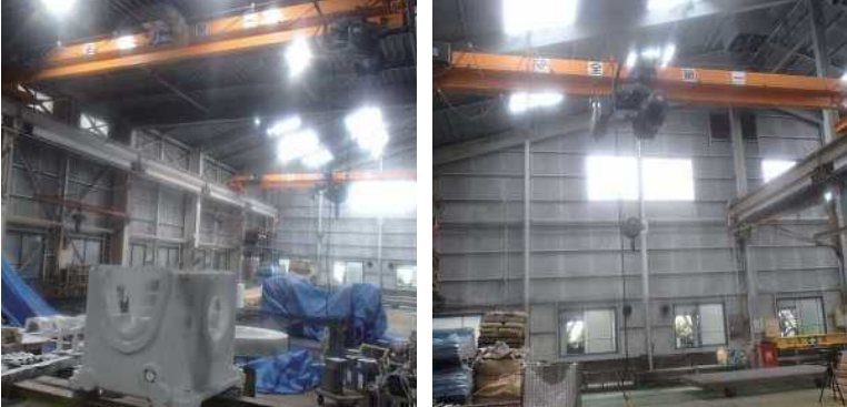
A棟クレーン室 B棟クレーン室
