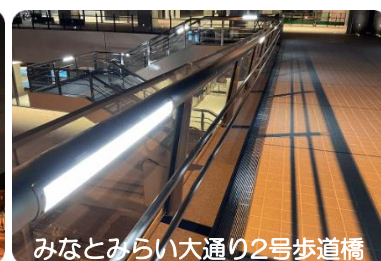
みなとみらい大通り2号歩道橋
