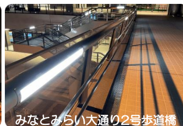
みなとみらい大通り2号歩道橋
