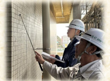
▲浮きや剥がれなどを確認する外壁打診検査
