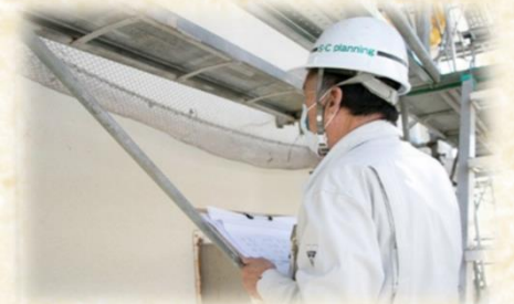
▲危険がないかなどを確認する足場の検査
