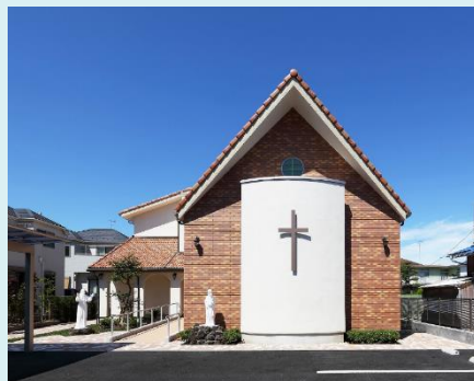
アトムメントのフランシスコ女子修道院新築工事
