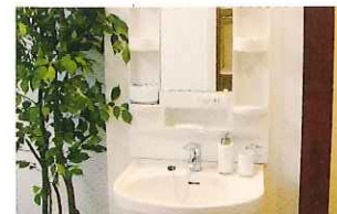
車いす対応洗面台
