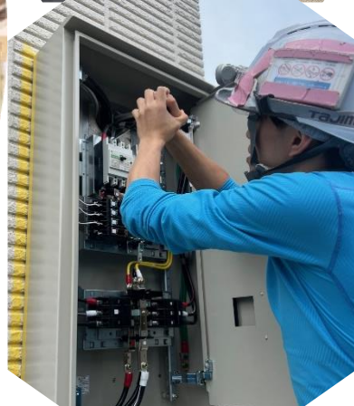
(開閉器盤の取付)
