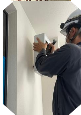
(メーターボックスの取付)
