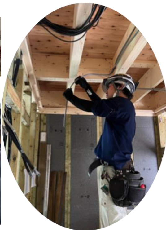
(配線工事の様子)
