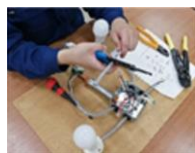
屋内電気配線
