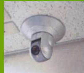
セキュリティ更新工事
