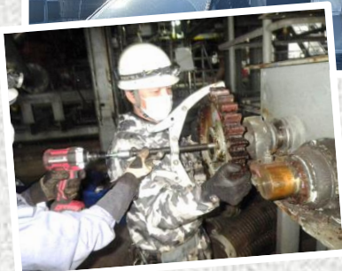
▶ 機械の据付作業
