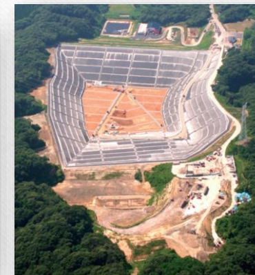
最終処分場全景
