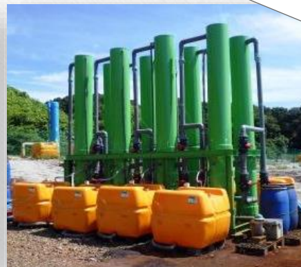
最終処分場では、脱臭塔を設置したり、 水質汚染が無いよう浄水施設もあります
