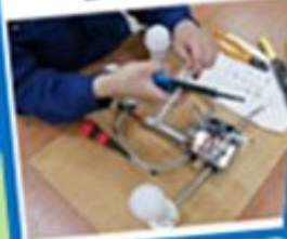
屋内電気配線
