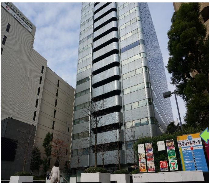
横浜STビル
