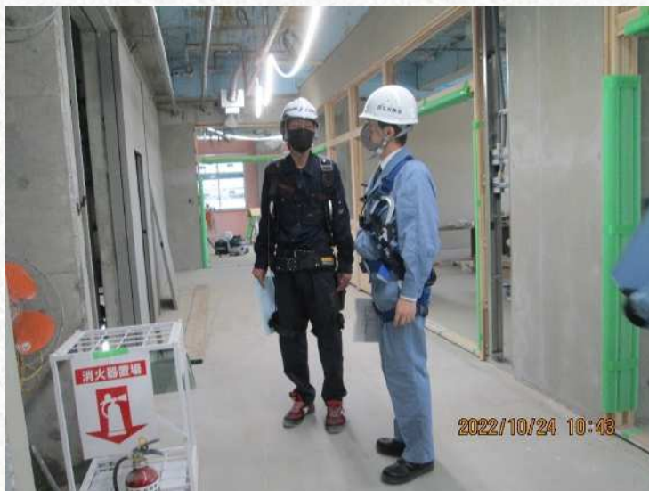
前田組・前屋敷組・田川組特定JVの担当者より、安全対策の説明を受ける中所局長
