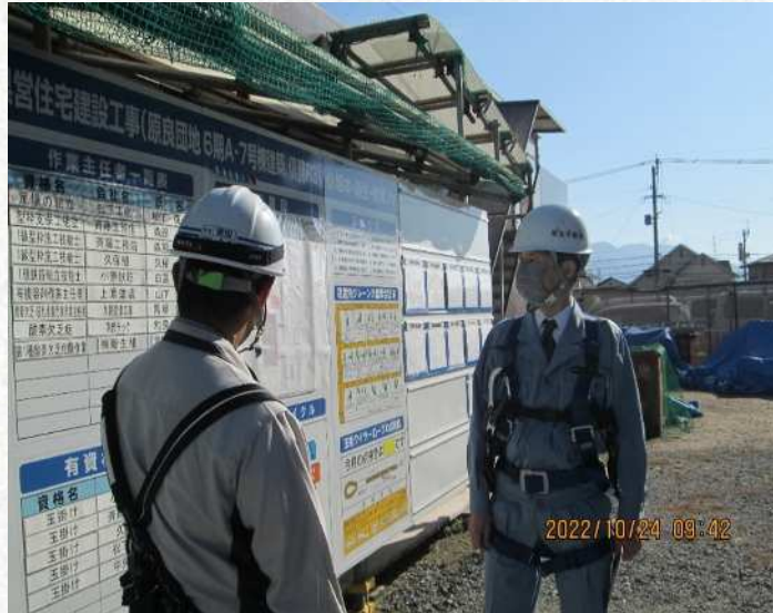
坂本建設・新生組・鶴留建設特定JVの担当者より、工事概要の説明を受ける中所局長
