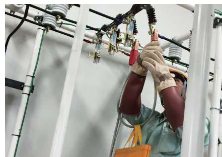
高圧設備工事
