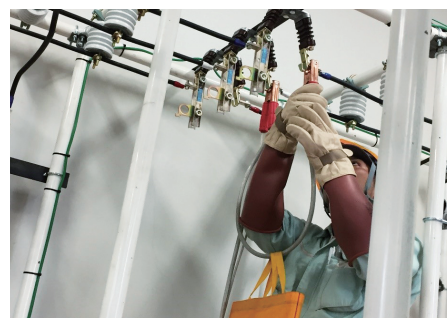
高圧設備工事
