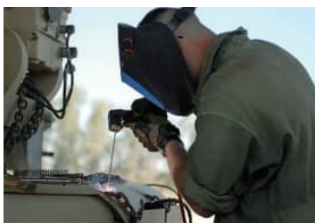
被覆アーク溶接
