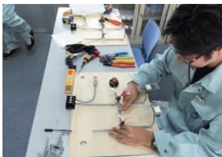
低圧設備工事 基礎
