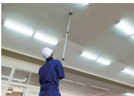
消防設備工事
