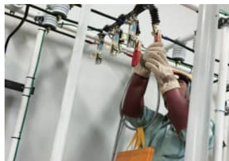
高圧設備工事
