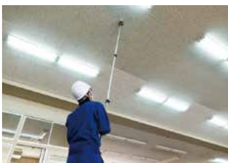
消防設備工事
