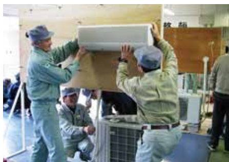
空調設備管理作業
