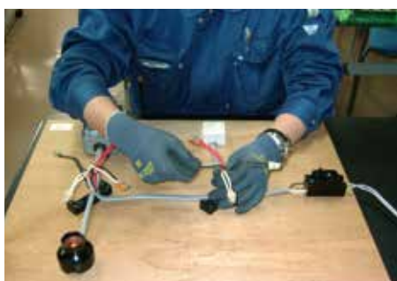
電気配線工事作業
