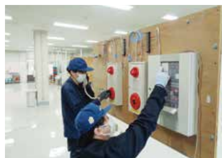
消防設備保全作業
