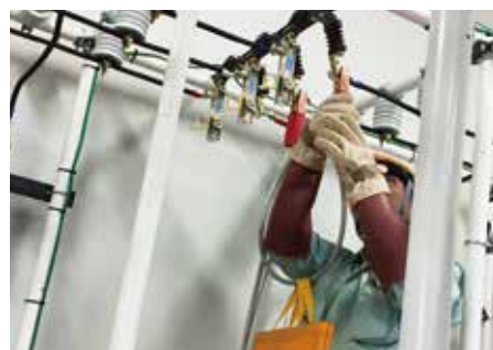
高圧設備工事
