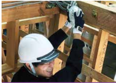
低圧設備工事 実践
