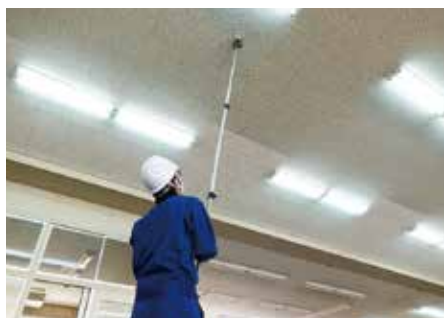
消防設備工事
