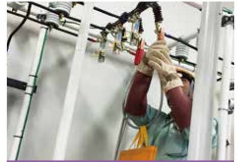
高圧設備工事
