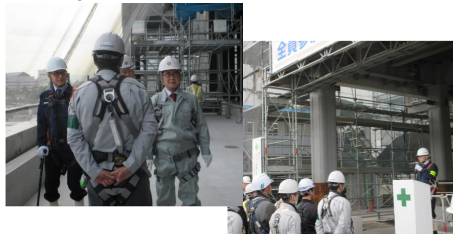
【②】12月10日実施の安全衛生パトロールの様子
