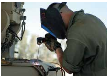
被覆アーク溶接
