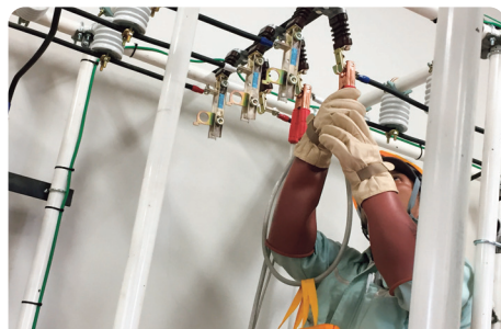
高圧設備工事
