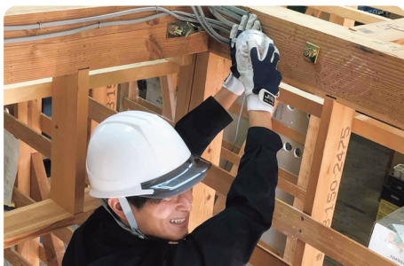
低圧設備工事 実践
