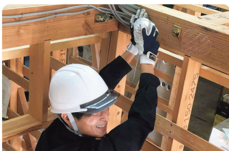
低圧設備工事 実践
