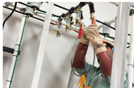
高圧設備工事
