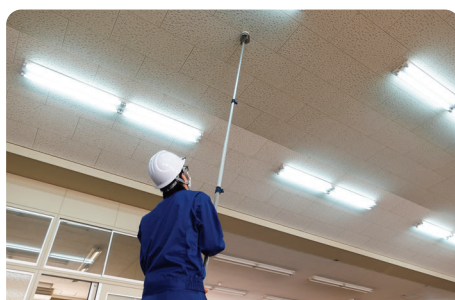
消防設備工事
