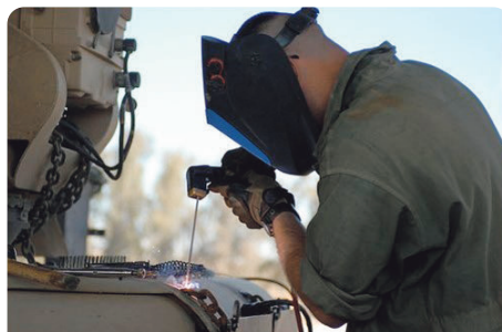
被覆アーク溶接作業
