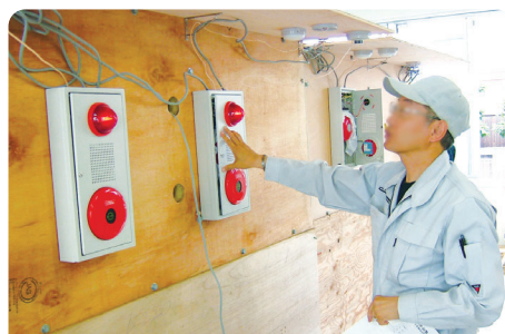
消防設備保全作業
