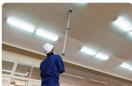
消防設備工事
