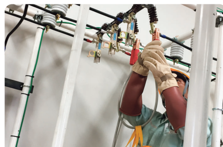
高圧設備工事
