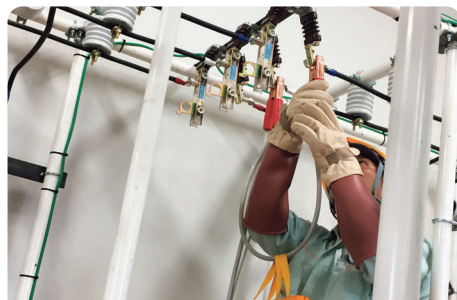
高圧設備工事
