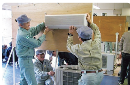
空調設備管理作業
