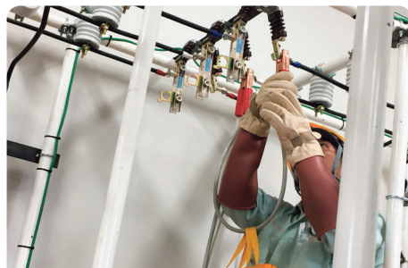
高圧設備工事
