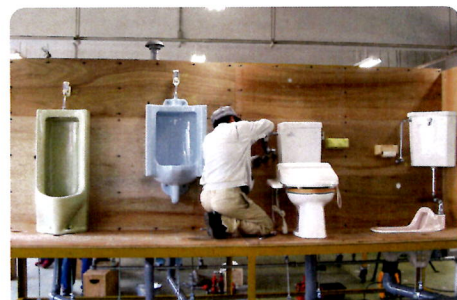
給排水衛生設備作業
