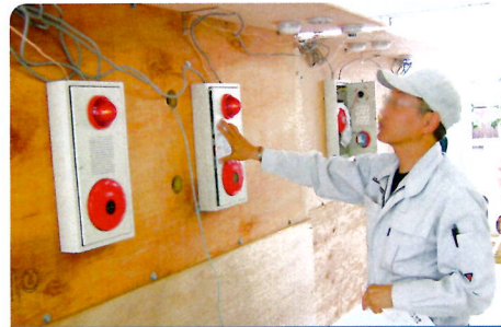
消防設備保全作業
