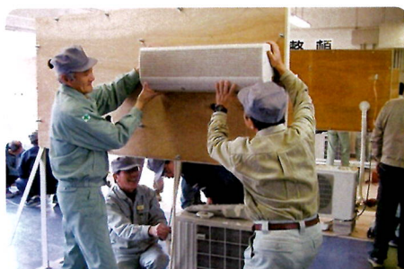
空調設備管理作業
