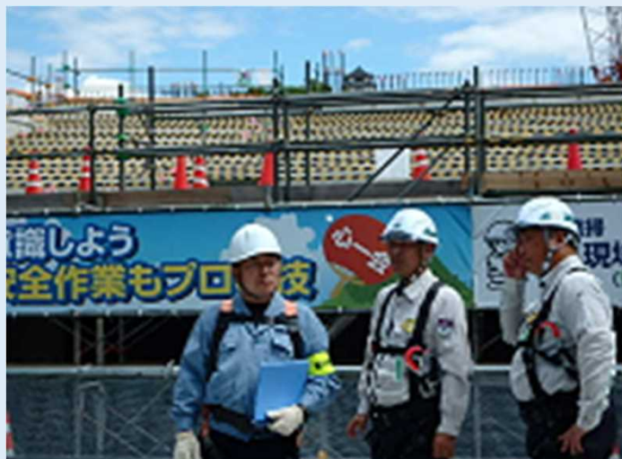
7月4日局・署合同で建設工事現場のパトロールを実施
