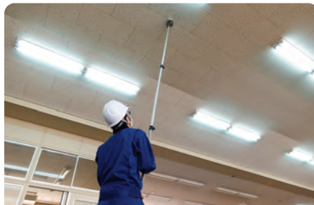
消防設備工事
