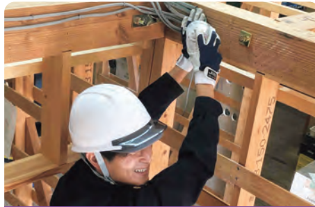
低圧設備工事 実践
