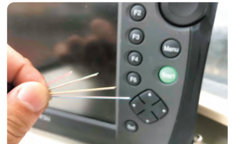
通信設備工事
