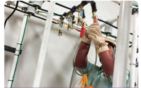
高圧設備工事
